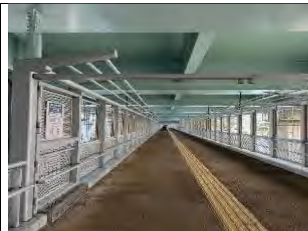
西海大橋內部景觀
