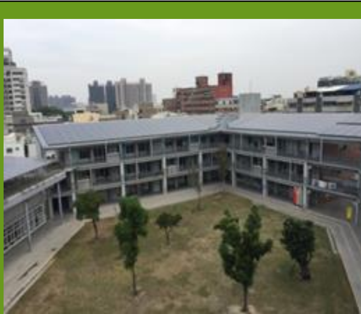
樂群國小屋頂 太陽能板
